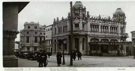
Edificio Castromil. Plaza de Pablo Iglesias (hoy Plaza de Galicia, Santiago de Compostela). Construido en 1922 y destruido en 1975. Rafael González Villar (1887-1941) fue el arquitecto de tan singular edificio.
